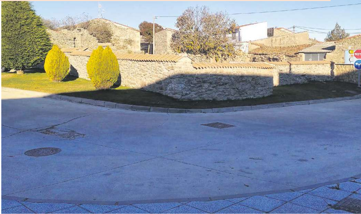
Nuevo aspecto de las proximidades del Complejo Turístico tras el desescombrado de dos ruinas y el arreglo de la pared de acuerdo con la ordenanza de rehabilitación y limpieza de solares.
