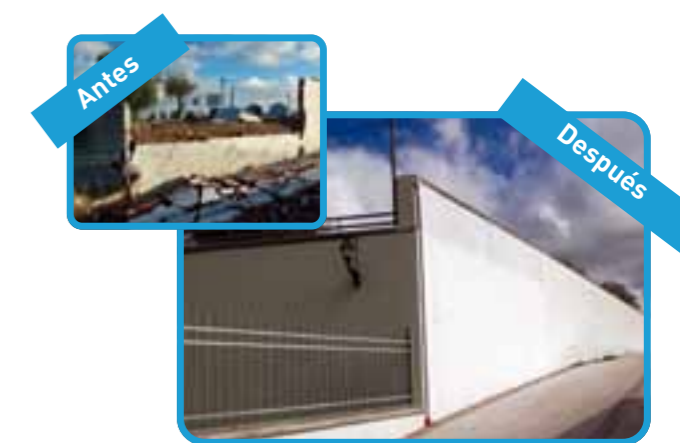
Muro del Cementerio
