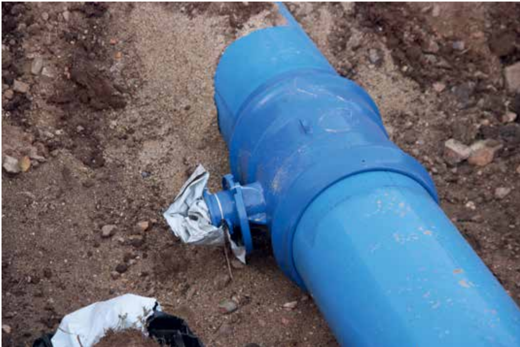
Detalle de empalme con acometida
