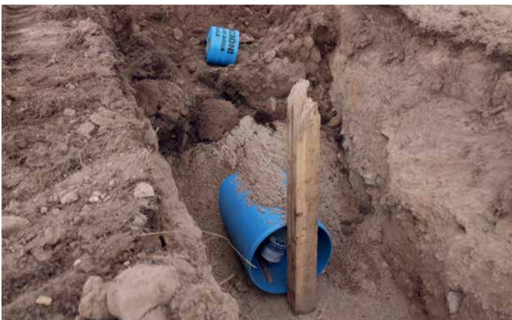
Detalle de la colocación de la tubería
