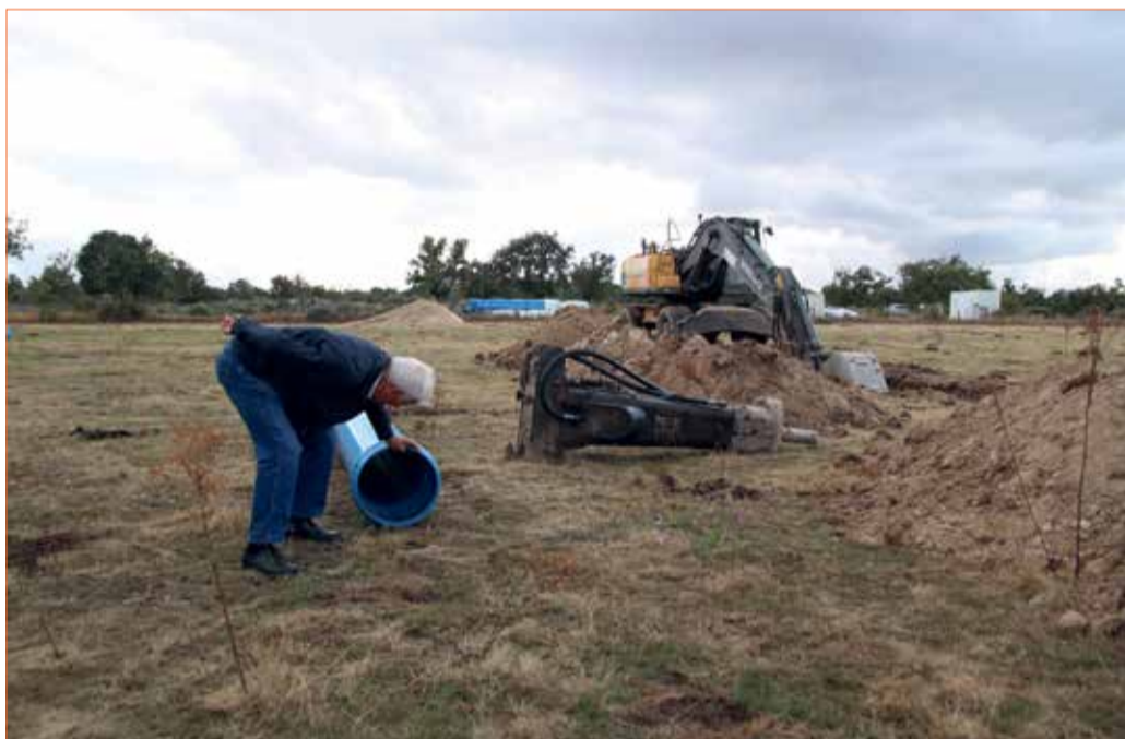
Tubería de 400 mm que aumentará la capacidad de Cabeza de Horno un 20 por ciento
