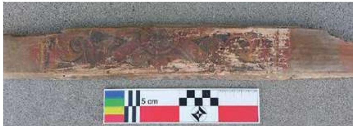
Detalle de una de las tablas con policromía “manipuladas” para ser reutilizadas en la cubierta
