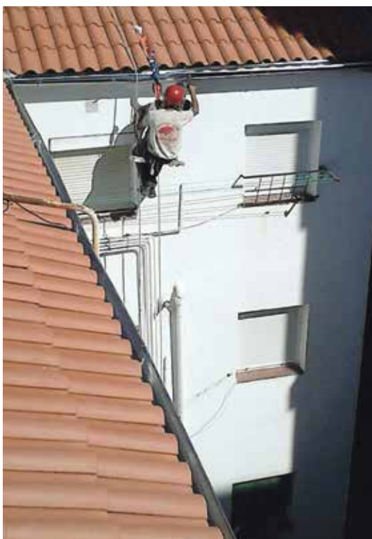
Trabajos de tejado y canalones nuevos, y pintura de patios
