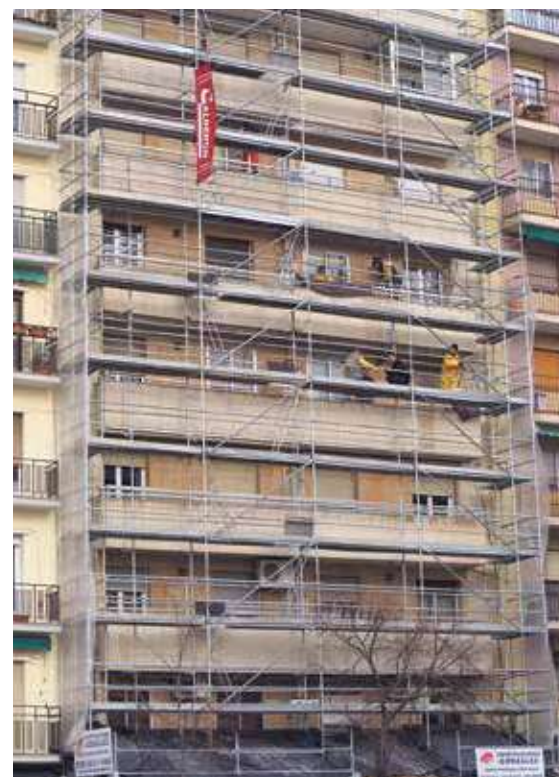
Trabajos de sujeción de piedras, limpieza y aplicación de consolidante en fachada
