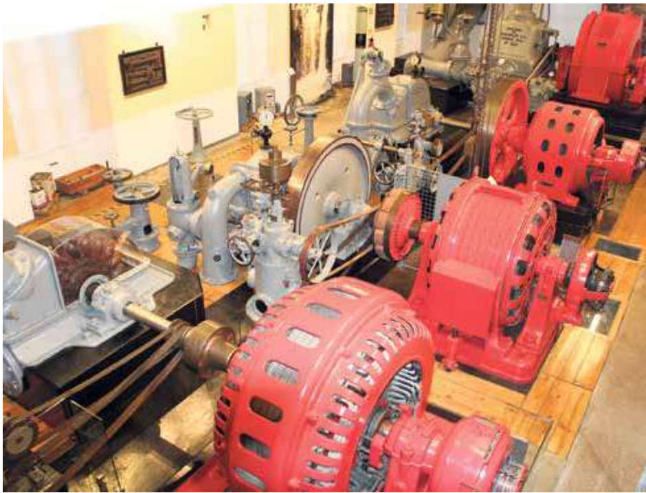
Sistema de turbinas y generadores en la sala de máquinas | FOTOS: MARTÍN-GARAY
