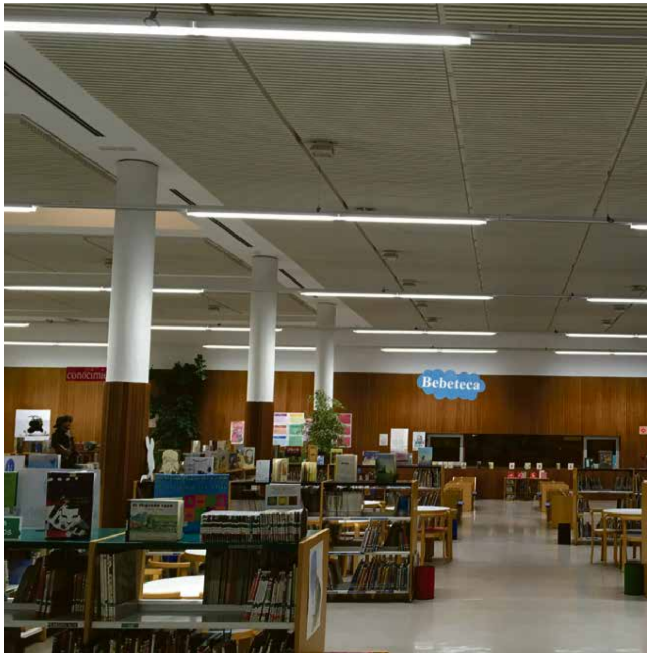
En la biblioteca Torrente Ballester han sido instaladas 35 placas solares para autoconsumo del edificio
