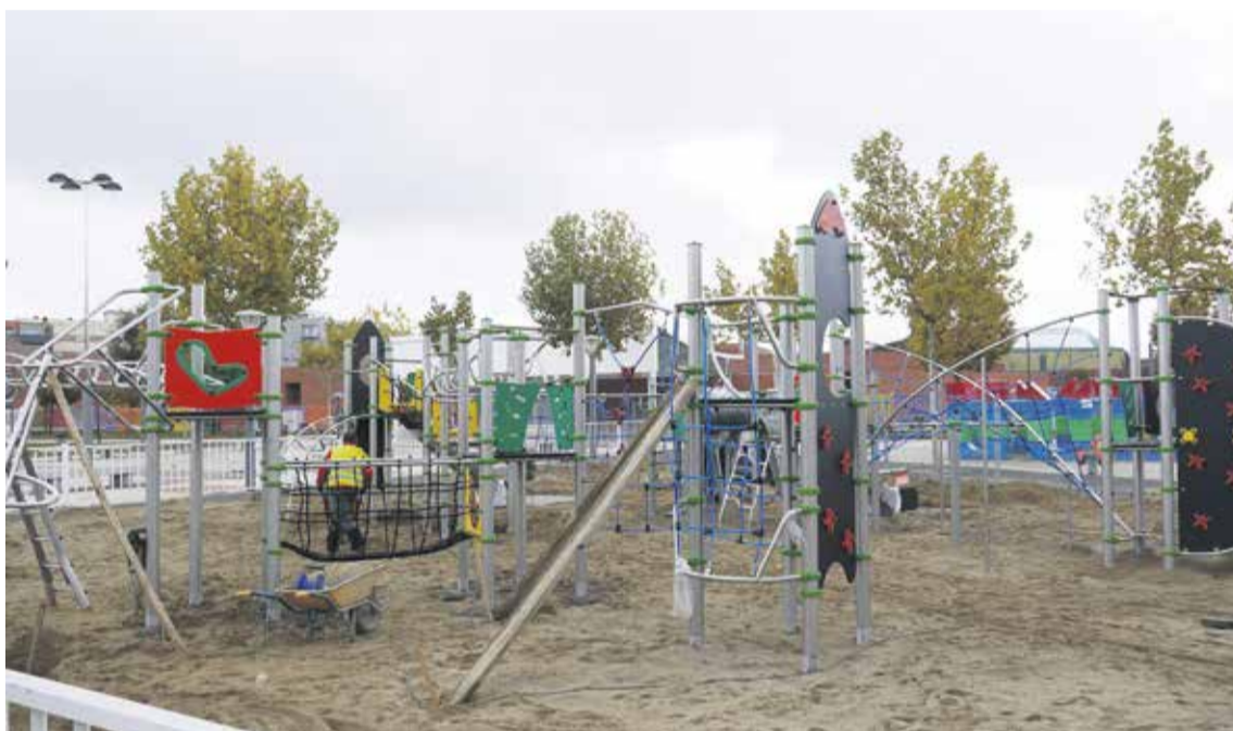
Los nuevos elementos están realizados en acero inoxidable y tienen patas de acero galvanizado | AYUNTAMIENTO
